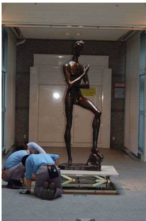
←免震台を固定しています。
