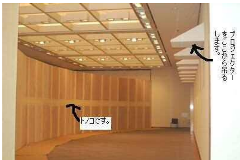
↑ 目地にトノコを塗って経師の準備。プロジェクターを付ける台も取り付け完了
