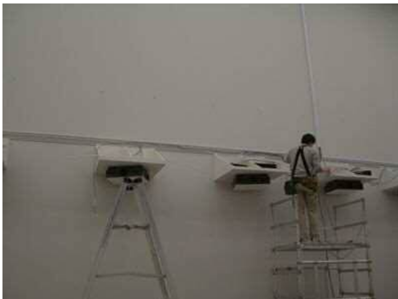
▲映像機器の配線中
