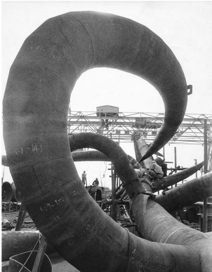
図17 《生命の樹》仮組の様子(写真提供:東海プラントエンジニアリング)
